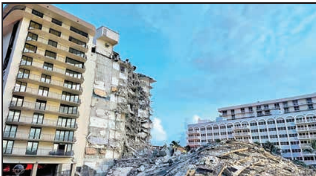
شکل ۱: ساختمان کاندو پس از فروریزش قسمتی از آن
