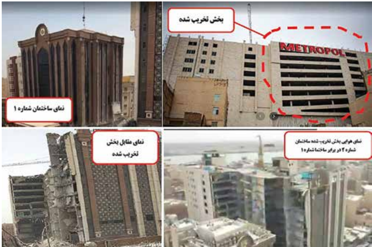
شکل ۱: تصاویری از ریزش رخ داده در ساختمان متروپل آبادان (مرکز مطالعات و برنامه ریزی شهر تهران)
